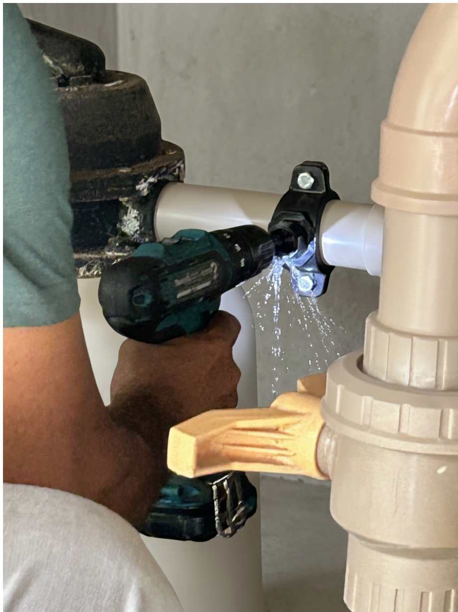
Figura 5: Instalação Colar Tomada Espigão
