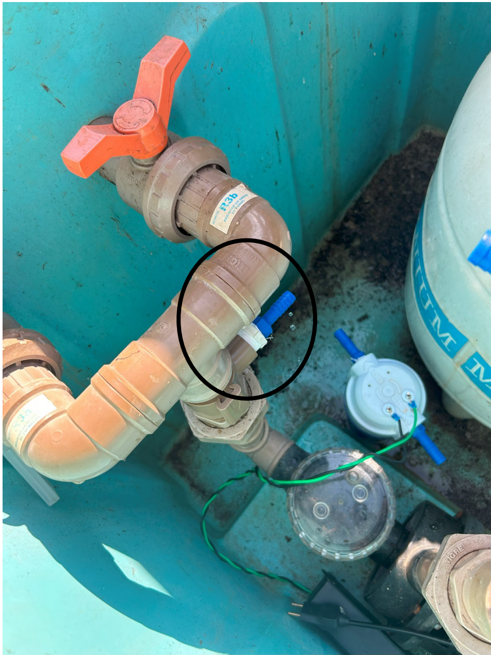
Figura 4: Instalação Colar Tomada Espigão Linha Sucção Ralo
