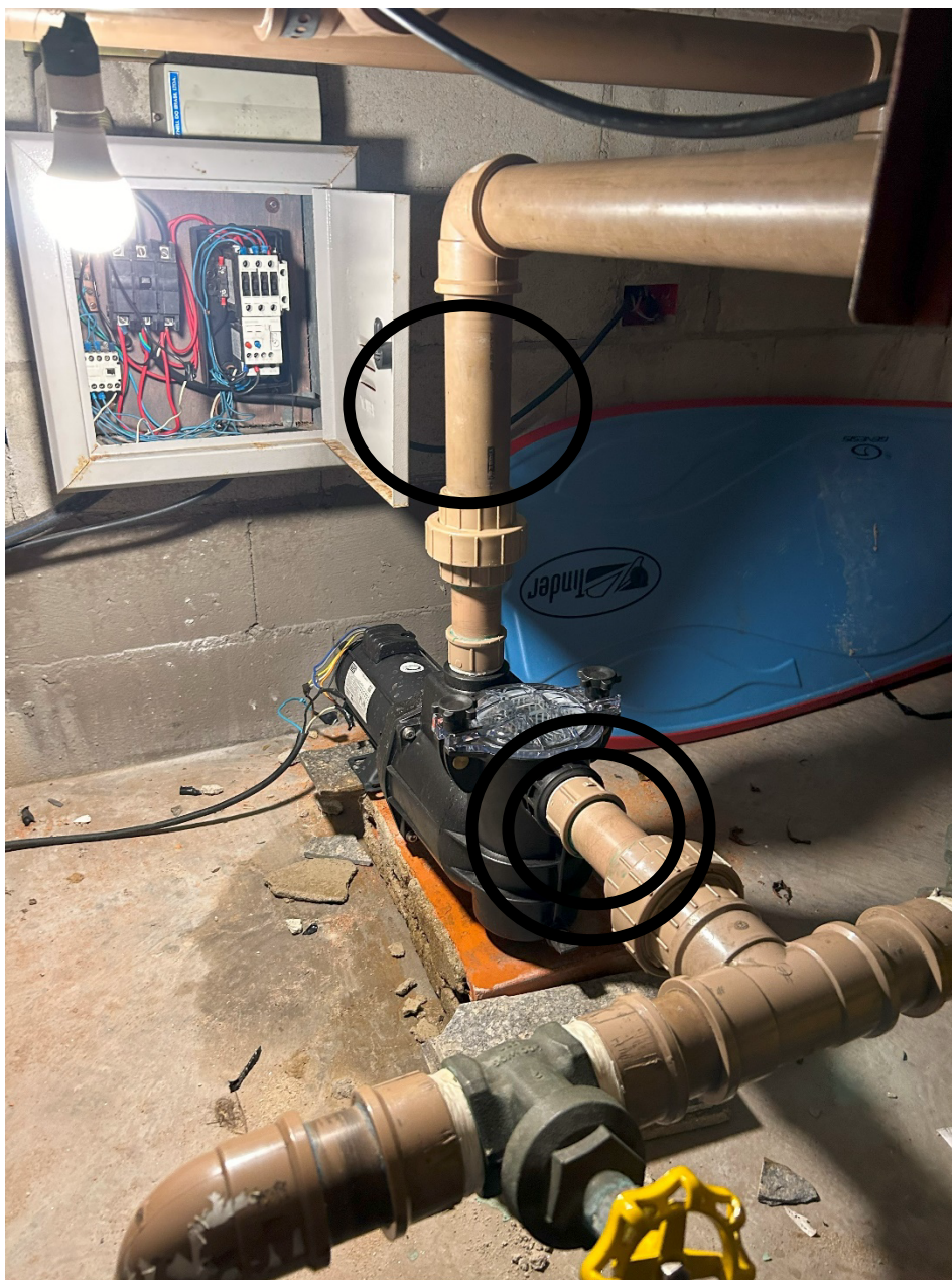
Figura 3 “Ilustração Pontos de Instalação Colar de Tomada.
