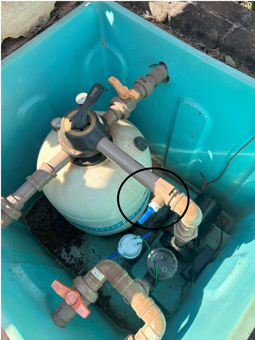
Figura 5: Instalação Colar Tomada Espigão Linha Pressurizada “Pós Bomba”
